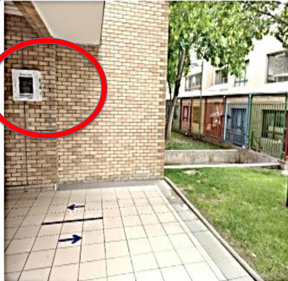
a) Edificio B, pasillo hacia edificio de preescolar.
